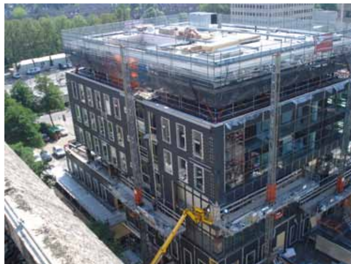
HSB bekleedt met keramische tegels.
